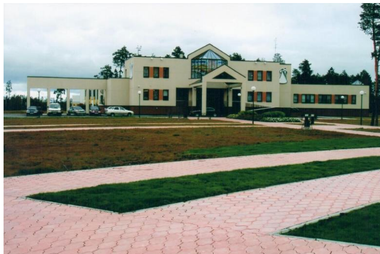
ФД.Оп.1.Д.792.Л.1 Общий вид центрального входа в здание городского ЗАГСа в летнее время, 2009
